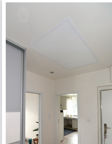
WE 630, strop, chodba
